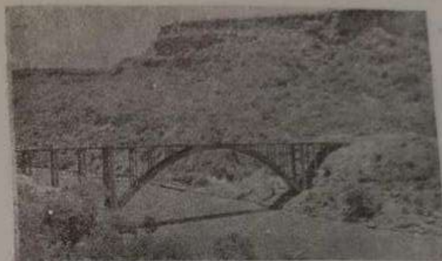
Vue du Pont sur l'Abbaye (Nil Bleu) View of the Abbaye Bridge (Blue Nile).
